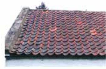
רעף בעל חתך רוחב דמוי האות S. מוכר בהולנד וסקוטלנד מאז המאה ה-17. מקנה לגג טקסטורה של גלי ים
