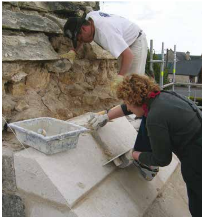
ברסי לה סיק - פינוי אבנים הרוטות, הנחת אבנים חדשות ומילוי בחומרי מליטה בקיר החפיר של המצודה, שנת 2004. צילום: ברונו לסטר
