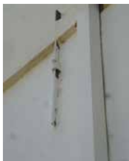
אור פלח ישר, מותחן מכופף על גבי העוגן ותריז להוספת לחץ. צילומים: יעקב שפר
